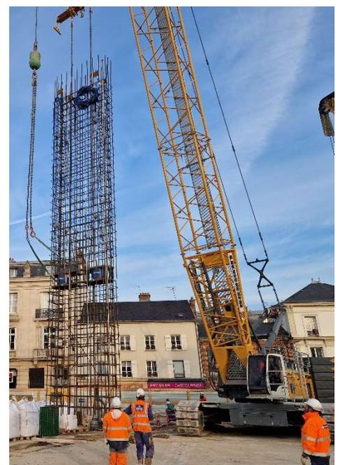
Einbau der Bewehrung mit O-Cell-Anordnung
